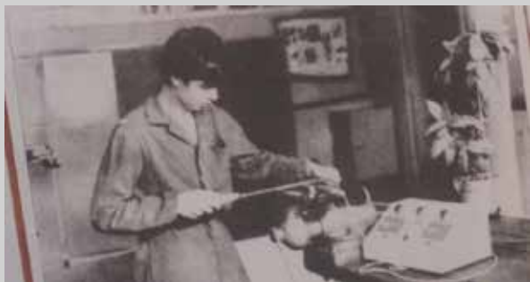
Obr. 1: Učeň při nácvičku pilování rovinných ploch na učební pomůcce “trenažer” (vedle svěráku) Zdroj: AOHK, f. OEZ s. p. Letohrad 1945–1958, I. část, sign. I/720, kart. 18.
