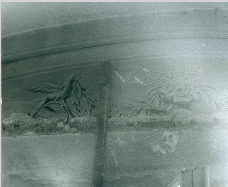
Obr. 10: Detail klasicistní výmalby v zámku Vlašim, odkryté při průzkumu v roce 1981, zřejmě práce Hermanna Kuena (foto V. Doležal, 1981, repro: Vladimír Doležal, Restaurátorská zpráva o průzkumu, provedeném v několika místnostech na zámku ve Vlašimi. Praha 1981, rukopis v Muzeu Podblanicka).
